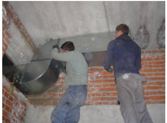
Montage der Lüftungsanlage
