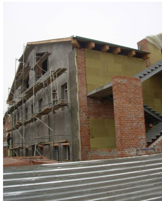
Isolierung der Außenseite des Gebäudes
