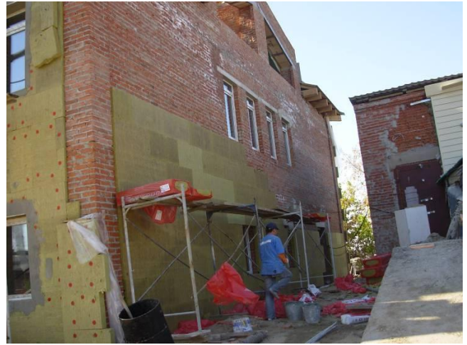
Isolierung der Außenseite des Gebäudes
