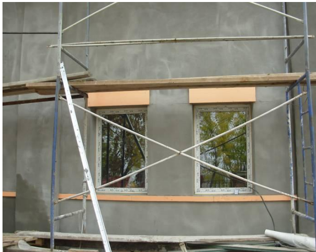
Montage der Fenster
