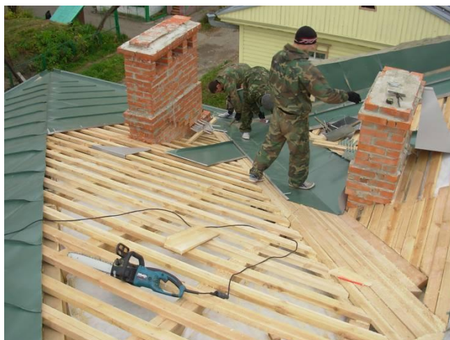
Ausbau des Dachstuhls und Dachdecken
