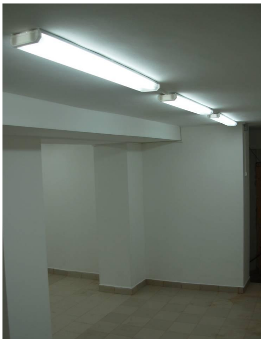
Montage der Beleuchtung und Fertigstellung des Fußgängertunnels
