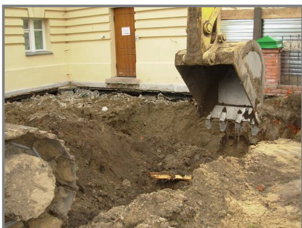
04.10. Ausschachten des Fußgängertunnels.
