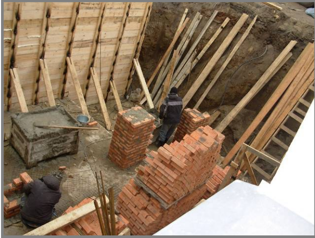
19.10. Die Pfeiler werden gemauert ...
