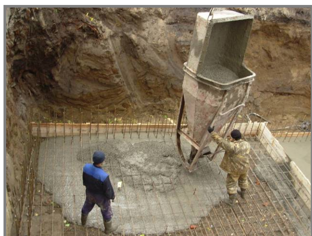
11.10. Armierung und Betonierung der Fundamente und des Fußbodens.
