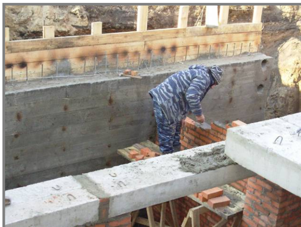
25.10. Die Zwischenwände werden gemauert.
