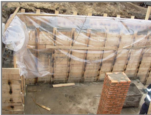
20.10. Montage der Wärmedämmung an den Betonwänden im Fußgängertunnel
