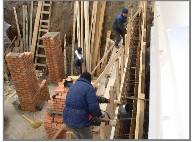
... und die Verschalung zum Giessen der Aussenwände montiert.
