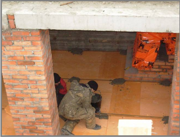
28.10. Montage der Wärmedämmung im Tunnel.
