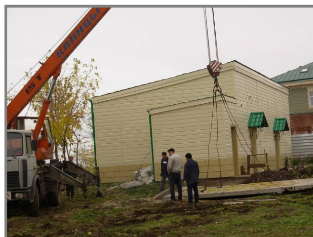
05.10. Montage der Betonplatten.
