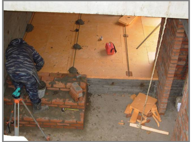
28.10. Die Treppe wird gemauert und verputzt.
