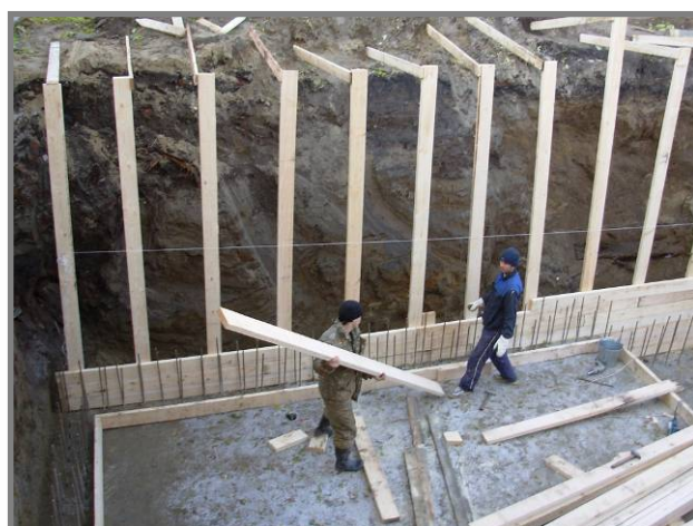
13.10. Montage der Verschalung zur Betonierung der Wände im Fußgängertunnel
