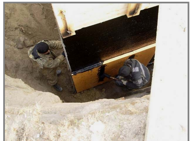
27.10. Wärmedämmung und Feuchtigkeitsisolierung der Außenwände.
