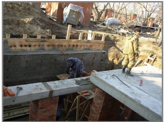
25.10. Montage der Deckenplatten
