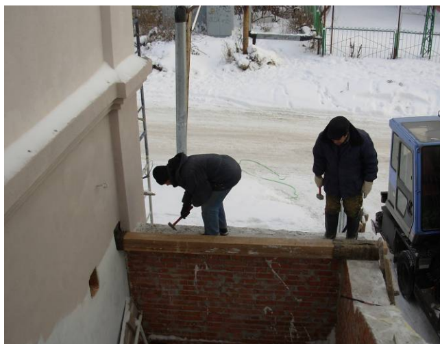
Überdachung des Notausgangs
