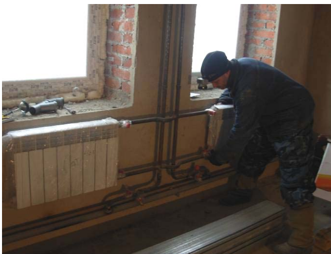
Montage der Heizungsanlage
