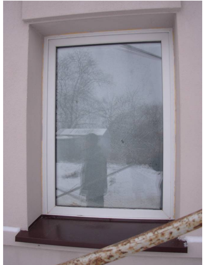
Montage der Wasserabläufe für die Fenster
